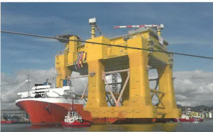
70 m hoch und mit einem Deck so groß wie ein Fußballfeld – die Dolwin Beta bindet Windenergieanlagen in der Nordsee an das Festland an.
